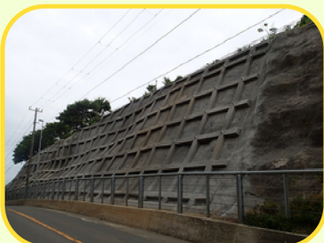
高所の作業で大きな危険があったが 誇りをもって完成させた
