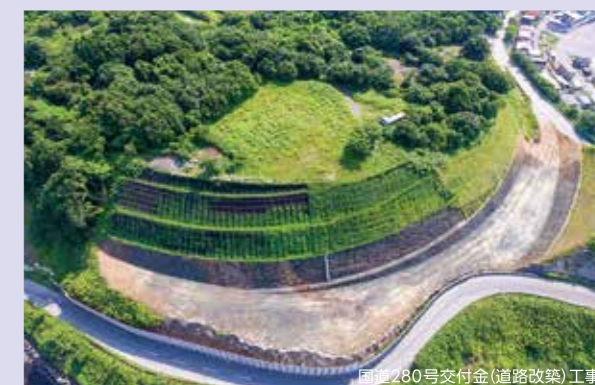
国道280号交付金(道路改築)工事
