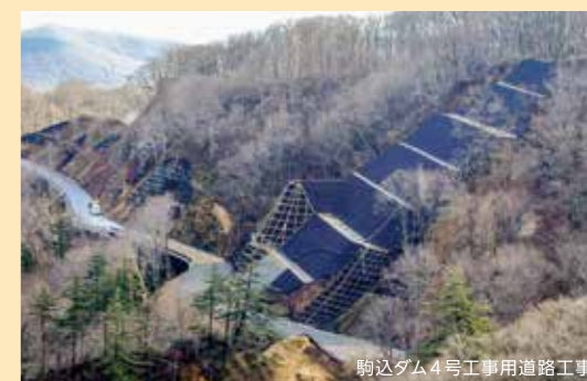
駒込ダム4号工事用道路工事
