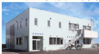
園舎改築工事 (本泉保育園)
