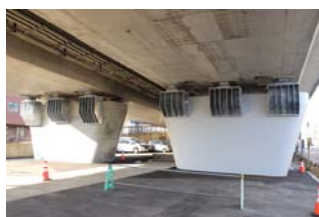
橋梁補修工事 (中央大橋)
