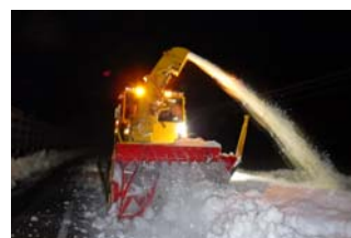
除排雪工事 (国・県・市)
