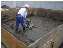
堤体掘削土を使用
