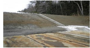
敷均し・転圧を繰返し完了(たかのこ)
