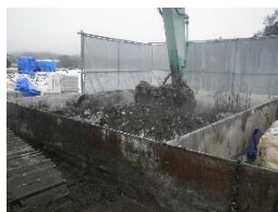
攪拌(固化剤投入後も攪拌)
