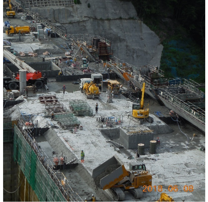
巡航RCD工法：ダムコンクリート高速打設 (RCDで働くダンプ:コンクリートを打設現場まで運搬)
