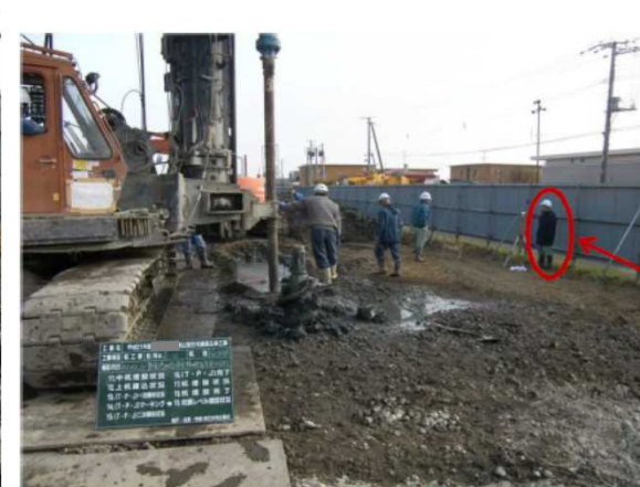
市監督員が現場で埋設完了を確認
