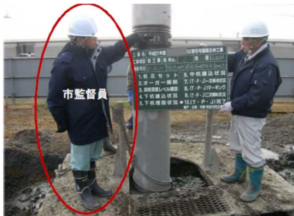
市監督員が現場で杭施工状況を確認
