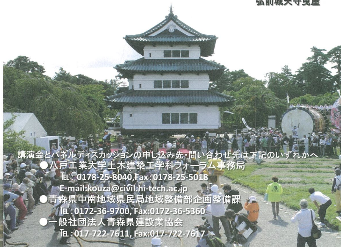
弘前城天守曳屋
