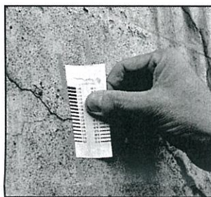
◆ひび割れ点検
