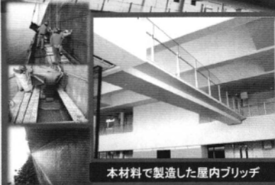
本材料で製造した屋内ブリッジ
