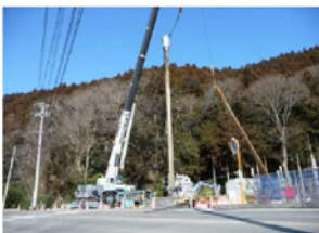
鋼矢板吊り込み状況
