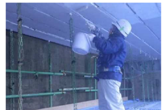
仕上げ塗装状況
