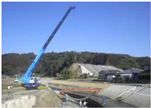
ブロックマット据付状況
