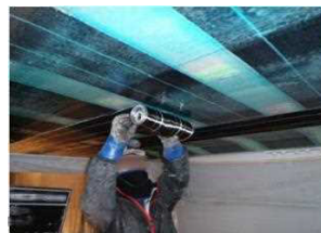
炭素繊維シート接着状況
