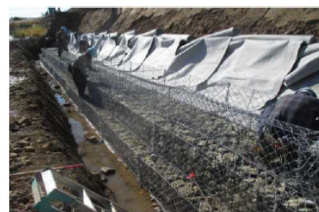
かご組立・据付状況
