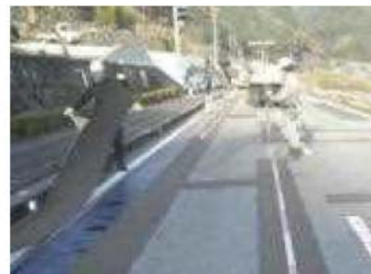
クラック防止シート張り作業
