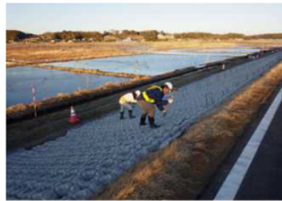
アンカーピン打設状況
