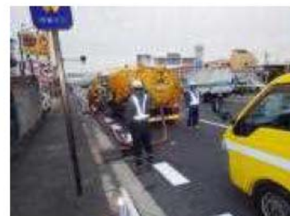
管渠清掃作業
