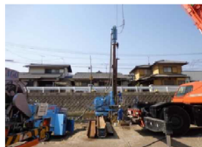
鋼矢板圧入状況
