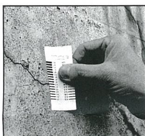
◆ひび割れ点検
