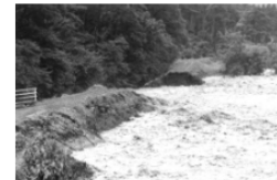
写真-1 荒川日食の食糧上流右岸堤防状況（福島県）
