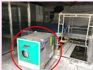
集塵機を設置し室内の換気を実施
