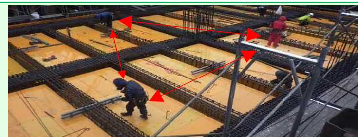
作業員の配置をブロック分けし密接した作業を回避
