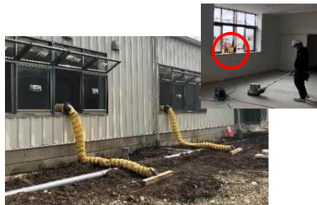
送風機を稼働し、埃を外部へ排出
