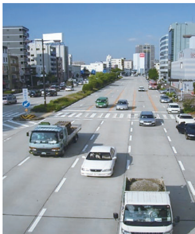
コンクリート舗装
