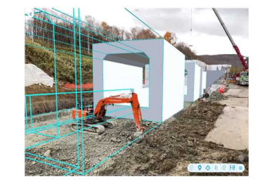
掘削作業時にARと比較
